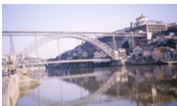
Brücke Dom Louis
