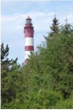
Leuchtturm auf Amrum
